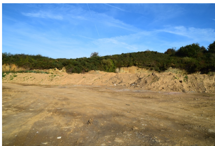
Zone décapée présente sur le site de Pont Pin
