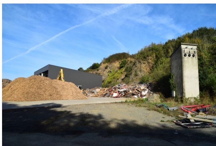
Plateforme de stockage et bâtiments
