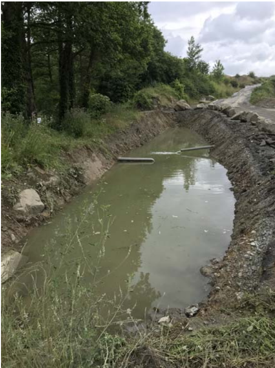
Vue sur le bassin Sud du site
